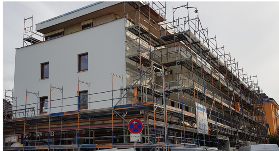
Der Abbau des Gerüsts am neuen Gemeindezentrum in der Peter-von-Fliesteden-Str. 2 hat begonnen: Die Fassade an der Nordseite ist schon größtenteils „ohne“ erkennbar.
