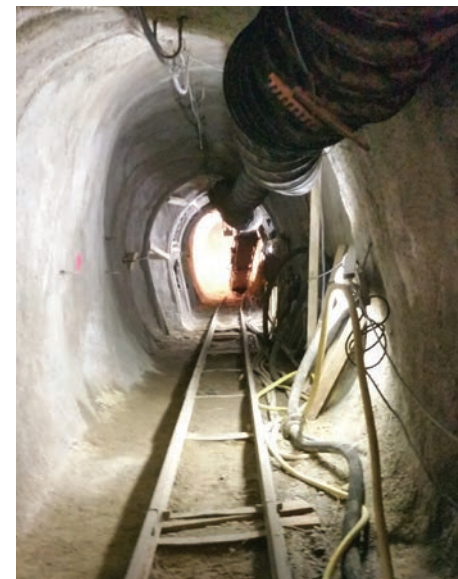
Schienen wurden für den Lorentransport verlegt.
