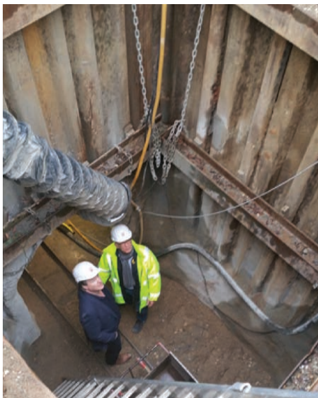
Direkt neben dem alten Bahnwärterhäuschen an der Aachener Str. geht's in die Tiefe.
